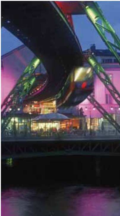
Die Schwebbahnstation Döppersberg/ Hauptbahnhof in Wuppertal Elberfeld
