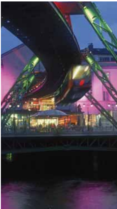
Die Schwebbahnstation Döppersberg/ Hauptbahnhof in Wuppertal Elberfeld
