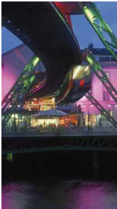
Die Schwebbahnstation Döppersberg/ Hauptbahnhof in Wuppertal Elberfeld
