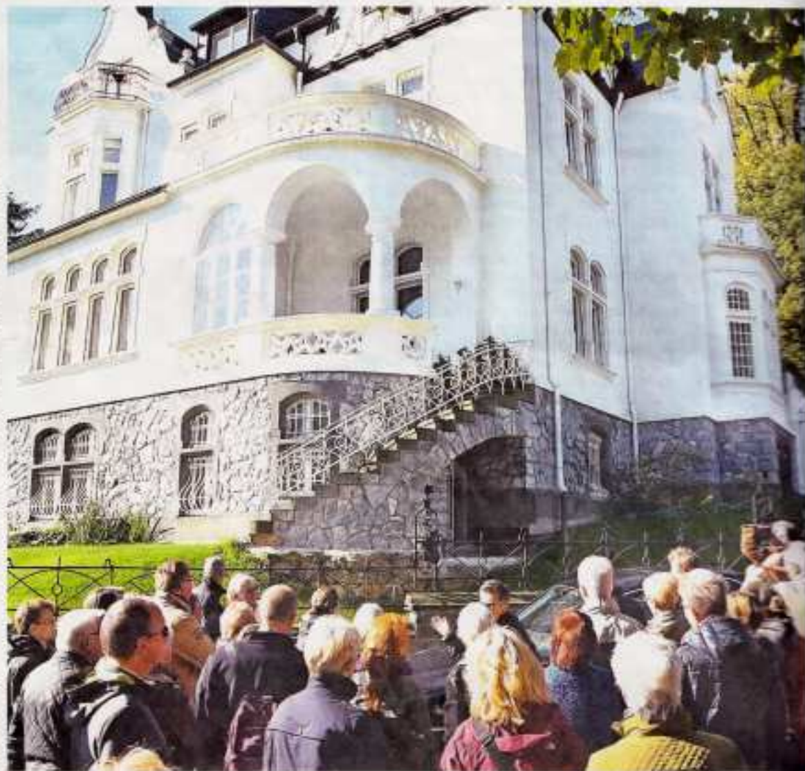
Informationen gab es unter anderem zu dieser Villa an der Goebenstraße/Ecke Moltkestraße...
