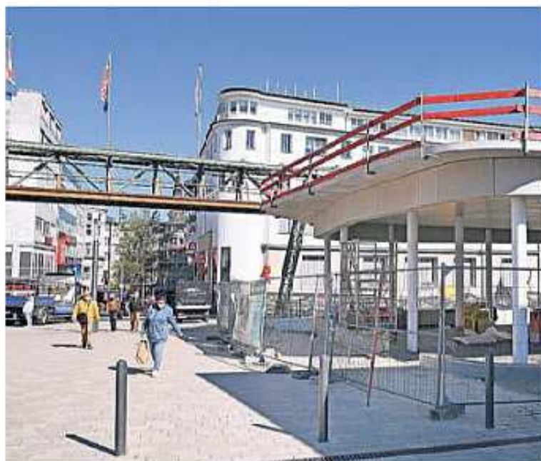
Der Pavillon mit Dachterrasse steht im Groben bereits. Er soll ein Aushängeschild werden.
