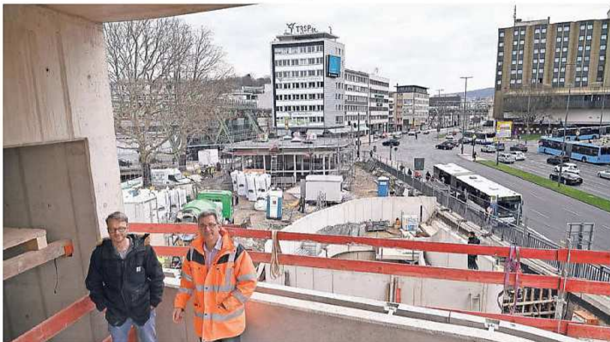
Architekt Holger Erke und Andreas Klein von der Stadt auf der Dachterrasse des Wuppertal-Marketing-Pavillons. Hinter ihnen ist der Hauptzugang zum Bunker zu sehen, der noch mit Bambus begrünt wird.
