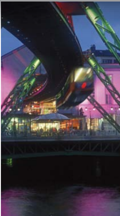
Die Schwebbahnstation Döppersberg/ Hauptbahnhof in Wuppertal Elberfeld
